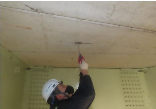
탄산화 깊이 측정 전경
